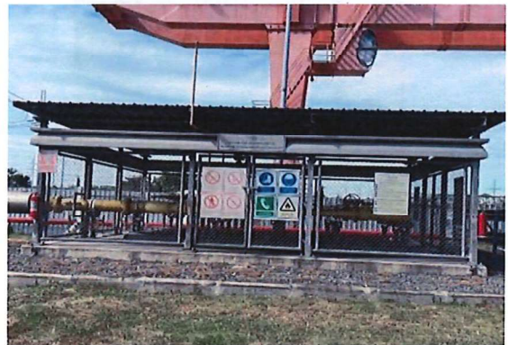
ภาพที่ 46 สถานีควบคุมความดัน และวัดปริมาณก๊าซ
