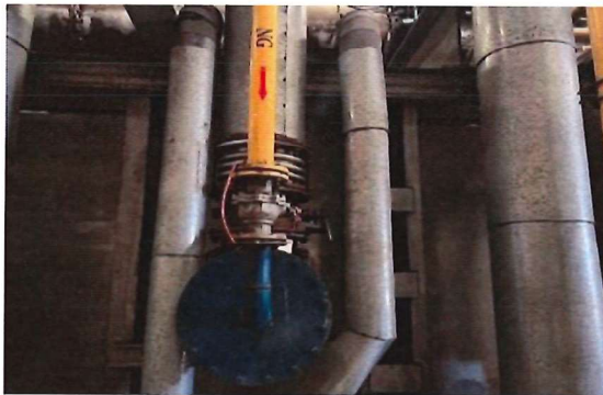
ภาพที่ 1 หัวเผาของเตาอบเหล็ก แบบ Ultra low NO x burners
