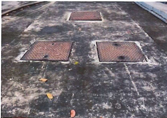
ภาพที่ 13 บ่อพักน้ำทิ้ง ขนาด 75 ลบ.ม.
